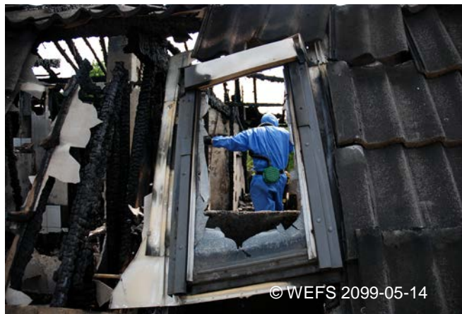
Trabajo de retirada del amianto después de un incendio
