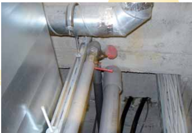
Dold sluten slinga i varmvattensystem som gav utrymme för Legionella -tillväxt – Källa: OMF1.
