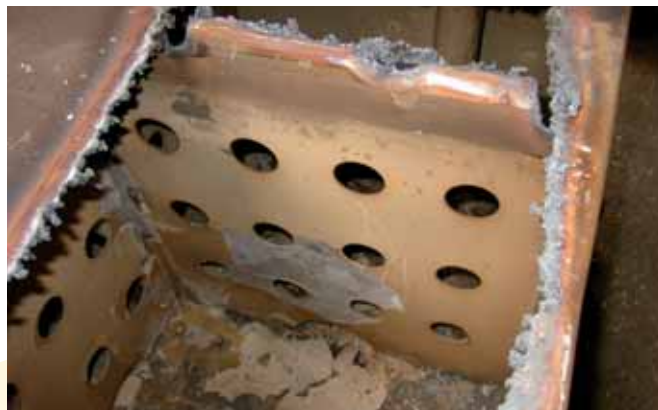
Sédiments et débris sur les parois et dans le fond des réservoirs d'eau — Source: ISPEL.
