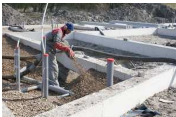
Figure 1: Épandage de coquillages pour l'isolation
