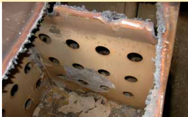
Sete ja jäätmed veemahutite seintel ning põhjas. Allikas: Ispes
