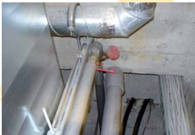
Kuumaveeringluse varjatud suletud süsteem, mis võimaldas Legionella kasvu. Allikas: OMFI
