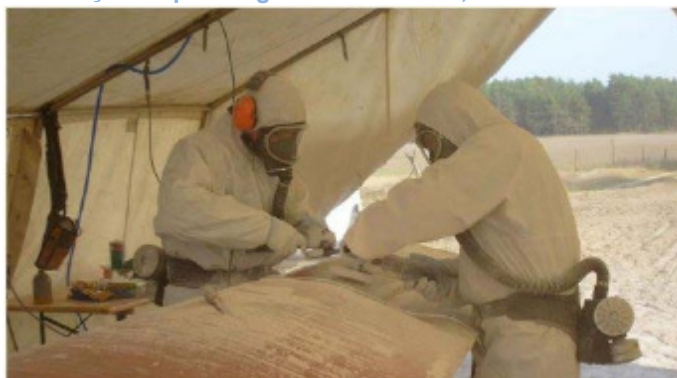
Figura 1: Reparação da laminação de pás de geradores eólicos, KOOP
