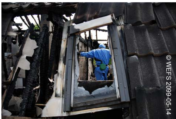
Odstranjevanje azbesta po požaru
