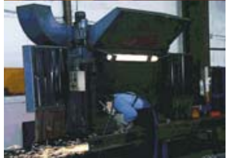
Vorher: Schleifarbeiten an Weichenherzstücken
