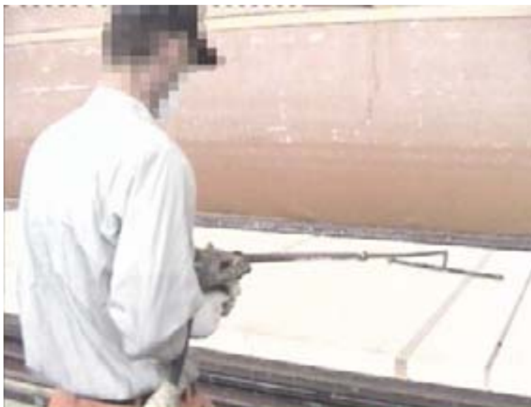
Nachher: Auftragen von Polyurethan-Klebstoff
