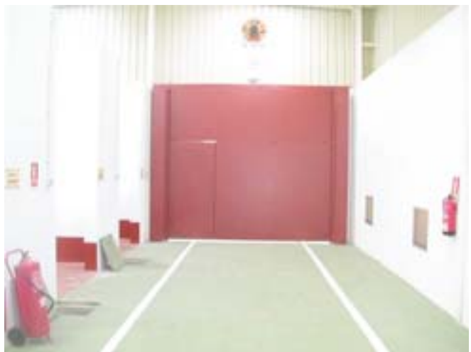
Innenraum im Hauptbereich des Lagers. Links die verschiedenen Lagerbereiche. Anmerkung: Das Lager verfügt sowohl über eine Zwangsbelüftung (oben Mitte) als auch über eine natürliche Belüftungsanlage (unten rechts).
