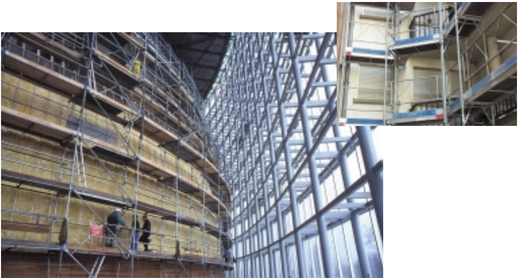
In basso: Impalcature nel cantiere del Parlamento Europeo di Strasburgo.
