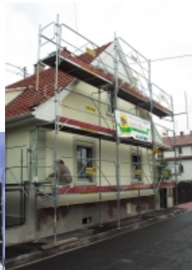
In alto e pagina successiva: impalcature che possono essere montate in modo sicuro per abitazioni private.
