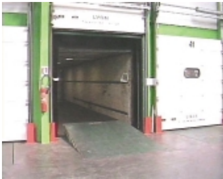
Esempio di stazione di lavoro in una società di trasporti cofinanziata dal CRAM: piattaforma adattabile ai vari tipi di rimorchi.
