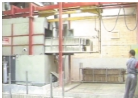
Esempio di cabina chiusa per la sabbiatura cofinanziata da una CRAM. Uso di un prodotto di pulizia ad acqua con un sistema di riciclaggio a circuito chiuso.
