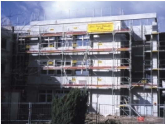
Vista generale di un edificio per uffici in fase di costruzione.
