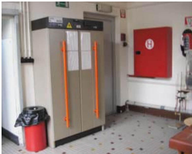
Armoire de sécurité pour le stockage des produits inflammables dans le laboratoire.
