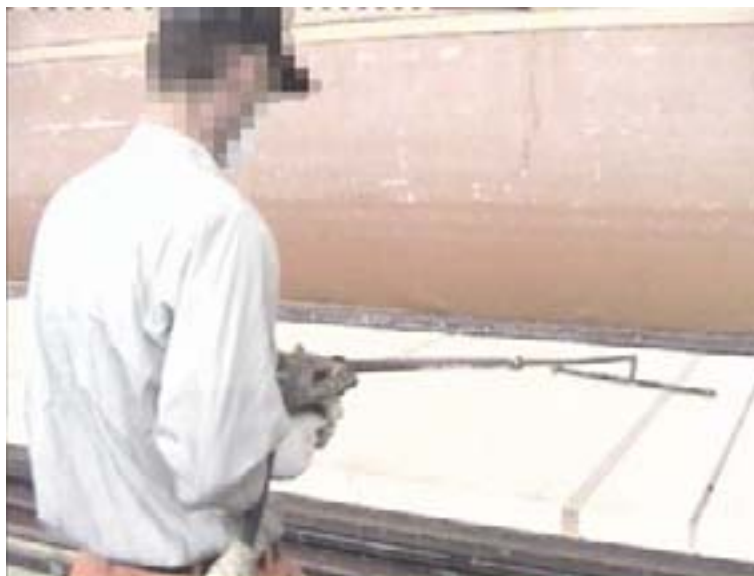
Après: application de colle polyuréthane.
