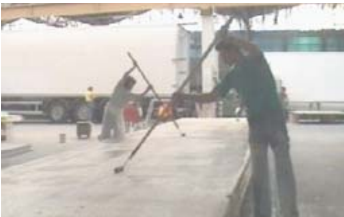
Avant: enduction de résine à l'aide de rouleaux.
