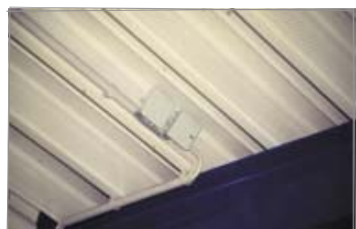
Abbildung 5: Detailansicht der Schall absorbierenden Stahltrapezblechdecke
