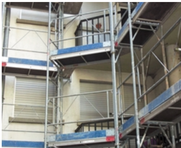
Genüst auf der Baustelle des Europäischen Parlament in Strasbourg.
