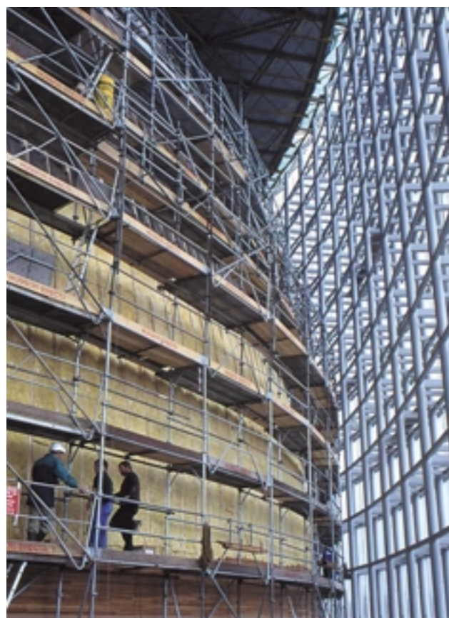
Gerüst auf der Baustelle des Europäischen Parlaments in Straßburg.
