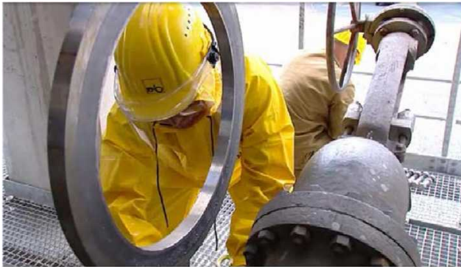
Figura 2: Xogħol ta' manutenzjoni f'impjant kimiku, BASF
