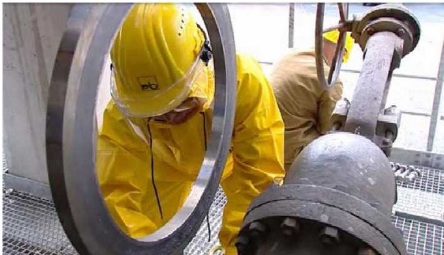
Εικόνα 2: Εργασίες συντήρησης σε χημική εγκατάσταση, BASF
