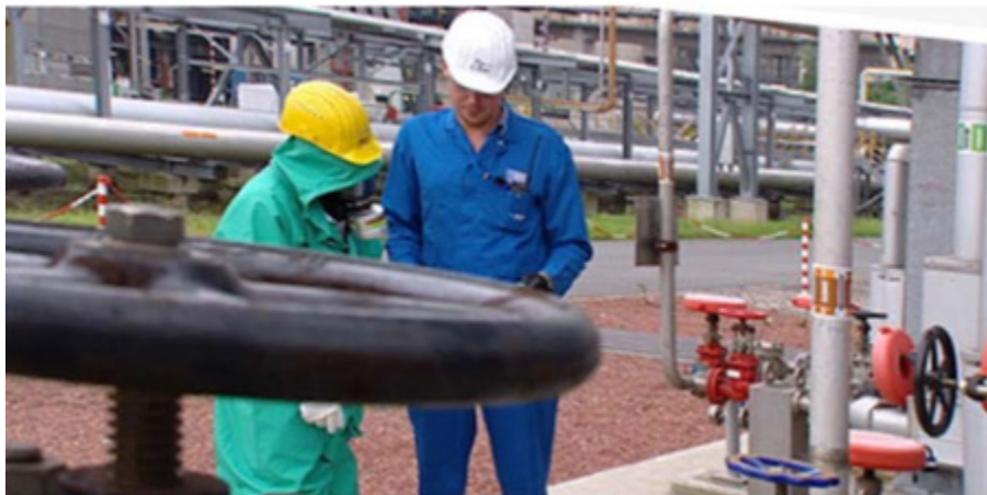
Εικόνα 3: Έλεγχος τελευταίας στιγμής: παράδοση της "άδειας για εργασία" στο πεδίο π.χ. για δραστηριότητες διακοπής γραμμών τροφοδοσίας, BASF
