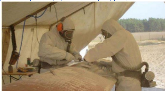
Εικόνα 1: Επισκευή στην επένδυση των πτερυγίων αιολικών γεννητριών, ΚΟΟΡ
