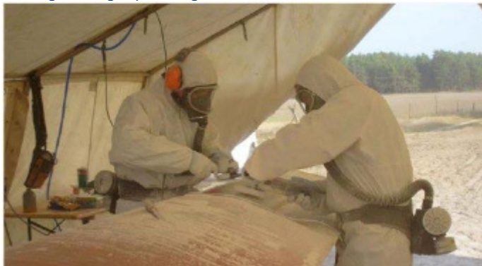
Figur 1: Reparasjonslaminering av vinger på vindgenerator, KOOP
