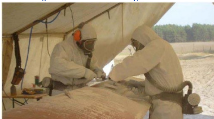
Obrázek č. 1: Oprava laminace listu generátoru větrné elektrárny, KOOP
