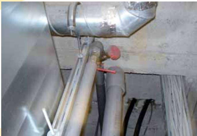
Ingassa magħluqa mohbija fis-sistema taċ-ċirkolazzjoni tal-ilma sħun li tat lok għat-tkabbir tal- Legionella — Sors: OMF1
