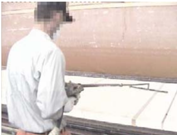
Après: application de colle polyuréthane.
